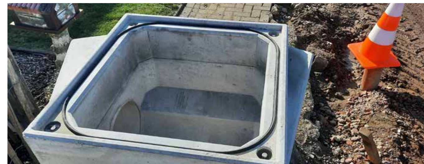
De voordelen van de kleine inspectieputten zijn groot: minder ruimte nodig voor plaatsing, minder graafwerken, minder kans om oude of bestaande leidingen te raken en meer ruimte voor de nutsleidingen ernaast.
