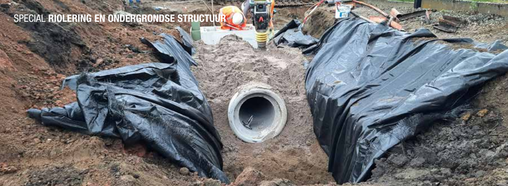
Voor het project Kleine Waterstraat en Kortestraat in Houtvenne (Hulshout) leverde Martens beton poreuze buizen en vierkante 80x80 inspectieputten.
