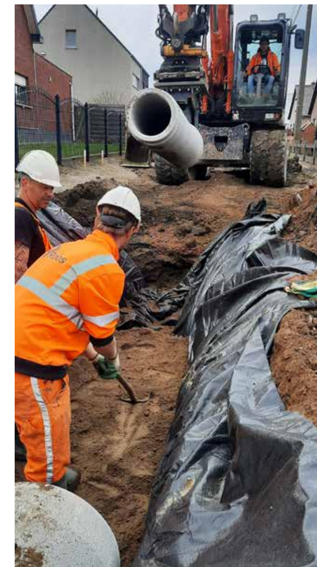
Roos Groep legt in Hulshout een volledig gescheiden rioleringsstelsel aan tot op perceelniveau.
