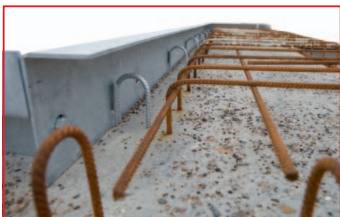
3 - De ingestorte omranding dient tevens als vloerbekisting
