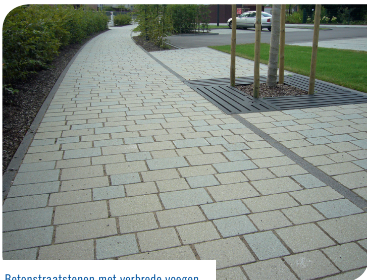
Betonstraatstenen met verbrede voegen
