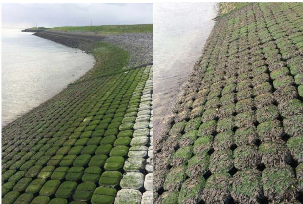
Afbeelding 2 Situatie december 2014. Linkerfoto: aangroei met darmwieren en (in het lagere deel, links op de foto) bruinwier Fucus spec. Op het achterliggende dijkgedeelte met basalt is de begroeiing met darmwier tot minder hoog in de getijdenzone ontwikkeld. Rechterfoto: aangroei met bruinwier Fucus spec. In het gedeelte dat onder het wateroppervlak ligt (links op de foto) is de aangroei minder dicht.
