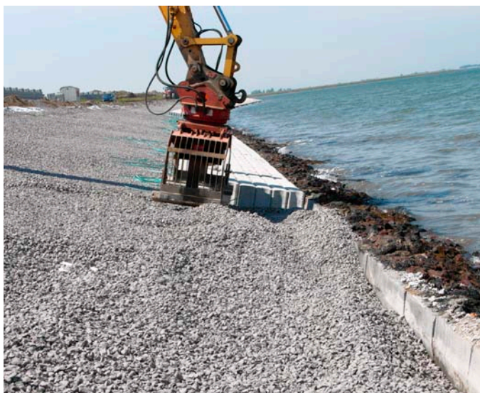
FOTO: PROJECTBUREAU ZEEWERINGEN
