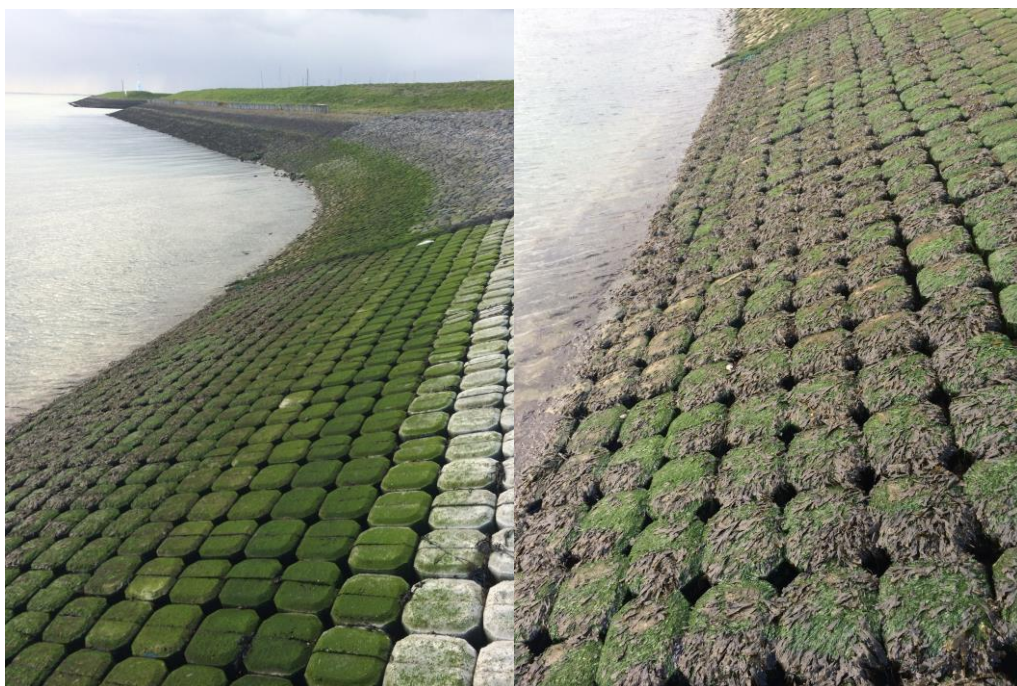
Afbeelding 4 Situatie december 2014. Linkerfoto: aangroei met darmwieren en (in het lagere deel, links op de foto) bruinwier Fucus spec. Op het achterliggende dijkgedeelte met basalt is de begroeiing met darmwier tot minder hoog in de getijdenzone ontwikkeld. Rechterfoto: aangroei met bruinwier Fucus spec. In het gedeelte dat onder het wateroppervlak ligt (links op de foto) is de aangroei minder dicht.
