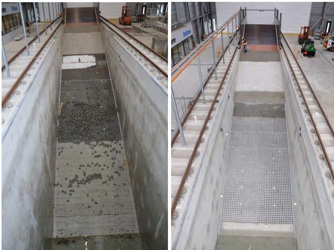
Foto 3.4 Links: na Sub-test P04. Rechts: voor Sub-test P04a (hersteld talud waarbij Grassblocks en Drainageblocks zijn verwijderd)
