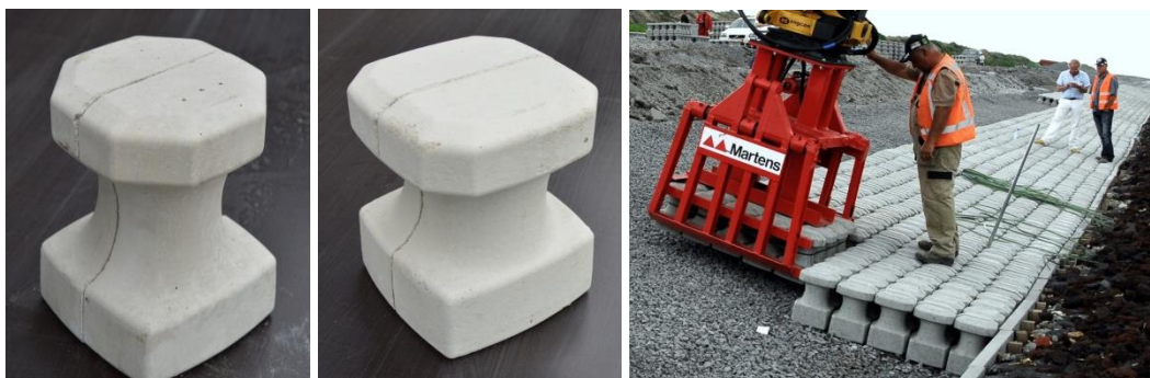
Figuur 1.1 Hillblock (links: type Slimblock, midden: type Basisblock, rechts: plaatsing op de dijk)
