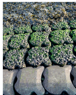
Haringmanblok (voorzijde) en Haringmanblok met ecotop.
