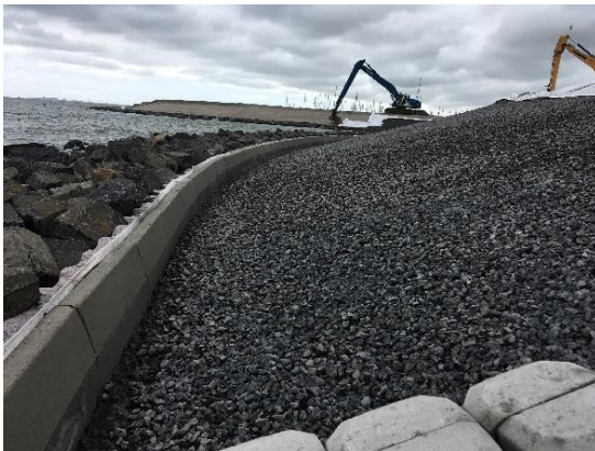
Figuur 2a afgeschuinde opsluitband
