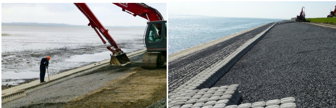
Figuur 1 a, b, c Granulaire laag egaliseren voor het beste zetresultaat
