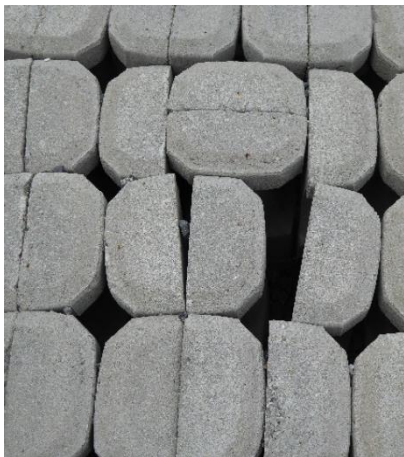
Figuur 6a Voorbeeld met Verkeerd zetwerk (onregelmatig zetwerk met grote openingen)
