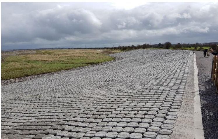
Figuur 2c Afsluiting met beton
