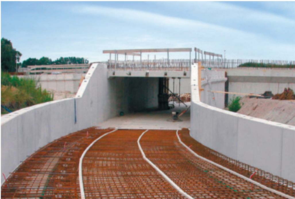
Duikerelementen toegepast voor een fietstunnel.
