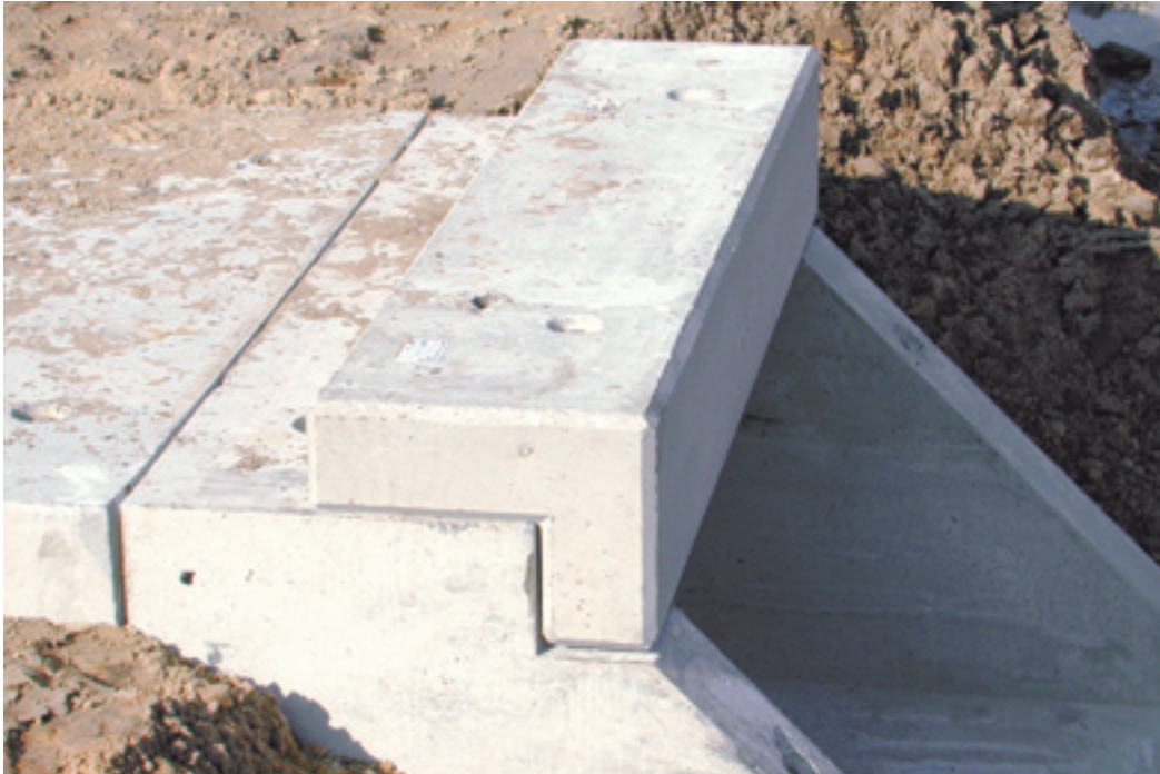
Rubberingduiker met uitstroomhoofd en kopbalk.
